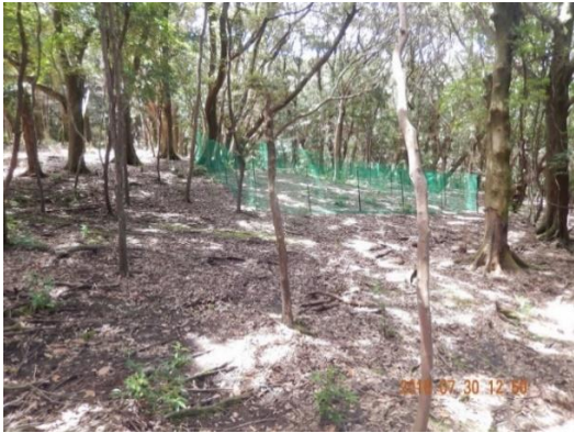
写真 3-2 完成したシカ防護柵の全景
