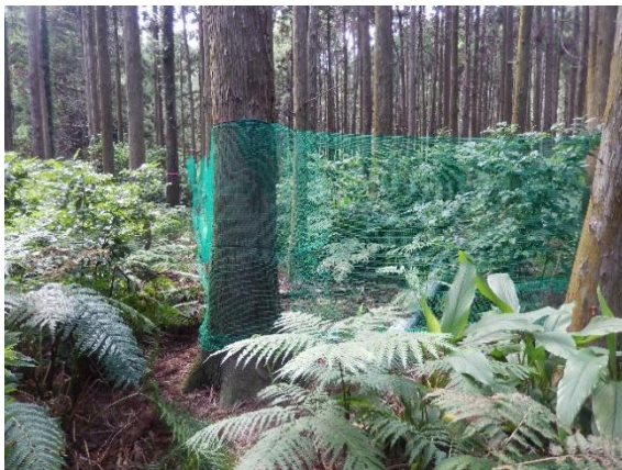
写真 3-12 完成した第二シカ防護柵
