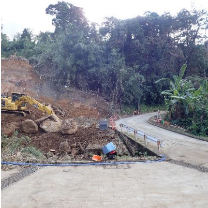
写真 1-3 金が迫ダム工事の取り付け道路工事
